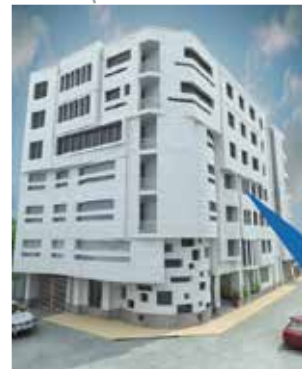
Budynek Amiri > Iran, Isfahan > Wdrożenie: 2013 > X modułowy Chiller @ Jednostki
