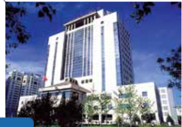
Budynek Amiri > Iran, Isfahan > Wdrożenie: 2013 > X modułowy Chiller @ Jednostki
